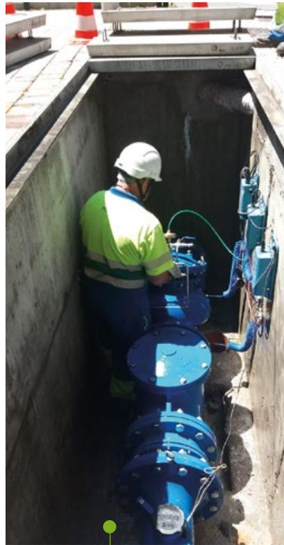
**IMAGEN DE UNA DE LAS SETENTA Y CUATRO ARQUETAS** instaladas en Salamanca con válvulas para monitorizar registrar y controlar la presión, el caudal, así como la calidad del agua
